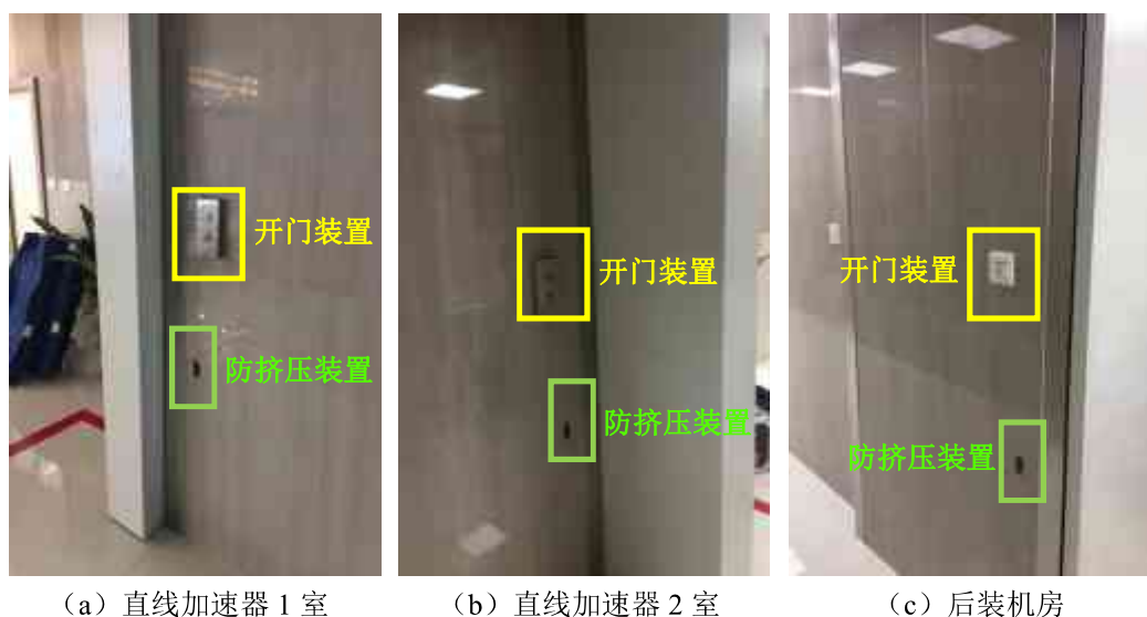
图 4-3 治疗室内开门装置及防挤压装置
