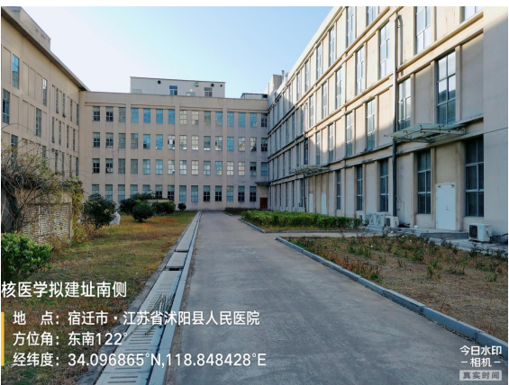
图 8-2 拟扩建放射性核素诊断项目南侧
