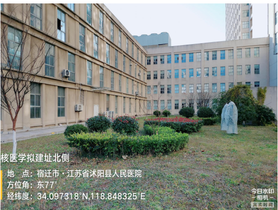
图 8-4 拟扩建放射性核素诊断项目北侧
