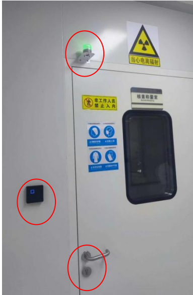
门禁锁、钥匙锁及工作状态指示灯 (称量室关闭状态亮绿灯)
