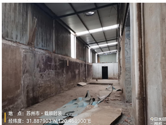
图 8-4 6#厂房西侧辅房
