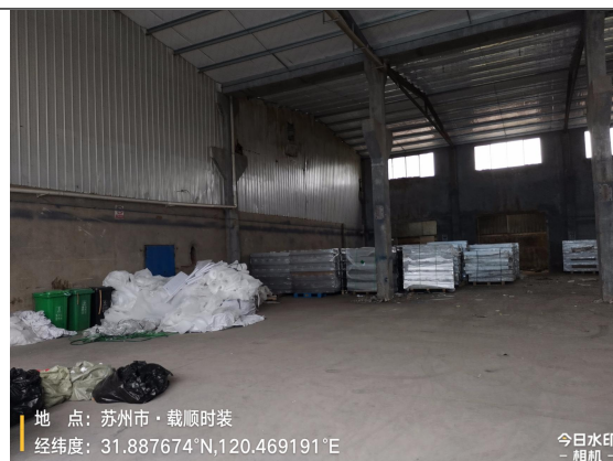
图 8-3 6#厂房南侧 7#厂房
