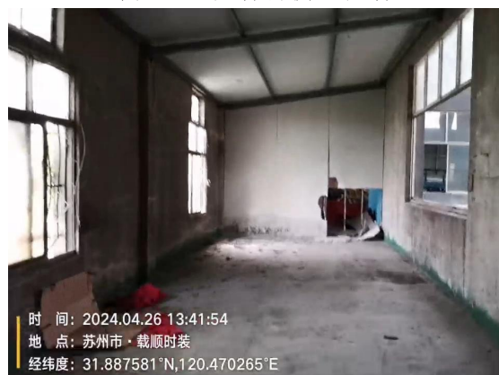
图 8-5 6#厂房北侧辅房
