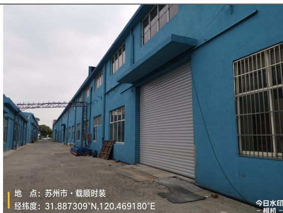
图 8-2 6#厂房东侧道路及 5#厂房
