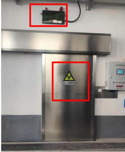
图3-14 工作状态指示灯和电离辐射警告标志
