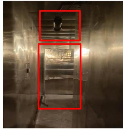
图3-17 迷道内视频摄像头和反射镜
