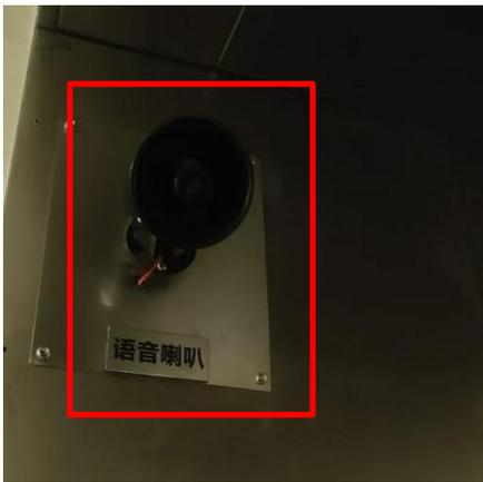
图3-16 迷道内音响警示装置
