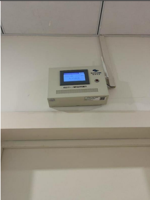
固定式X、 \gamma 辐射监测报警仪 (准备室入口)
