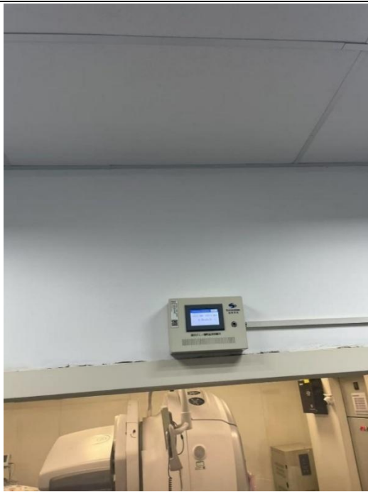
固定式X、 \gamma 辐射监测报警仪 (显像控制室内)
