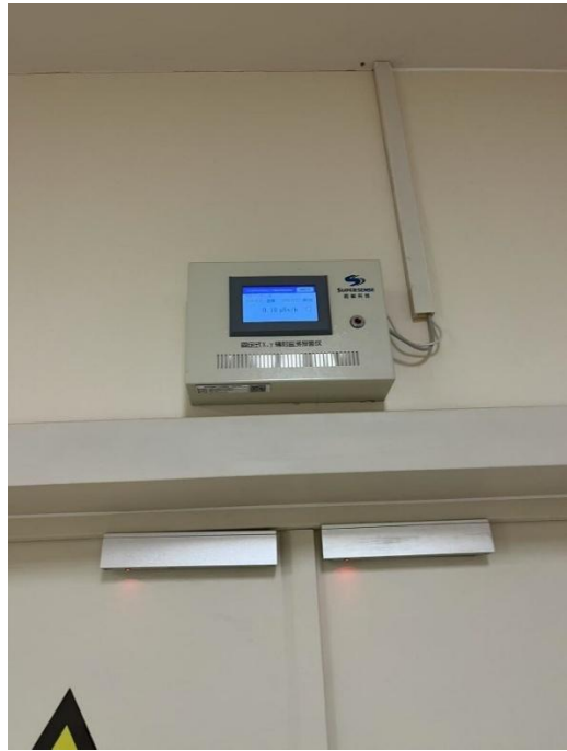
固定式X、 \gamma 辐射监测报警仪 (控制区入口)
