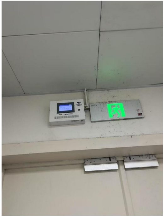
固定式X、 \gamma 辐射监测报警仪 (控制区出口)
