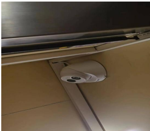
图3-11 屏蔽室内监控探头
