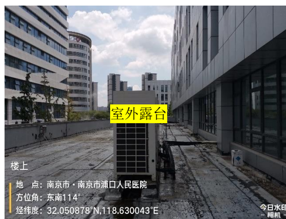
图 8-6 核医学场所拟建址楼上
