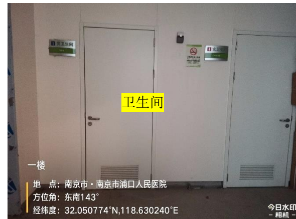
图 8-2 PET/CT 机房拟建址东侧
