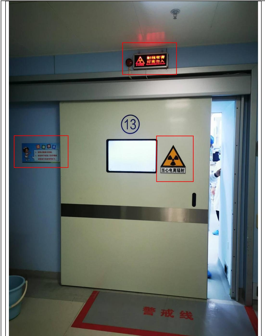
图 3-1 本项目 DSA 手术室防护门上电离辐射警告标志及工作状态指示灯
