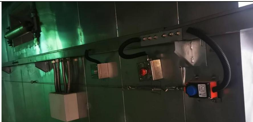
加速器机房拉线开关
