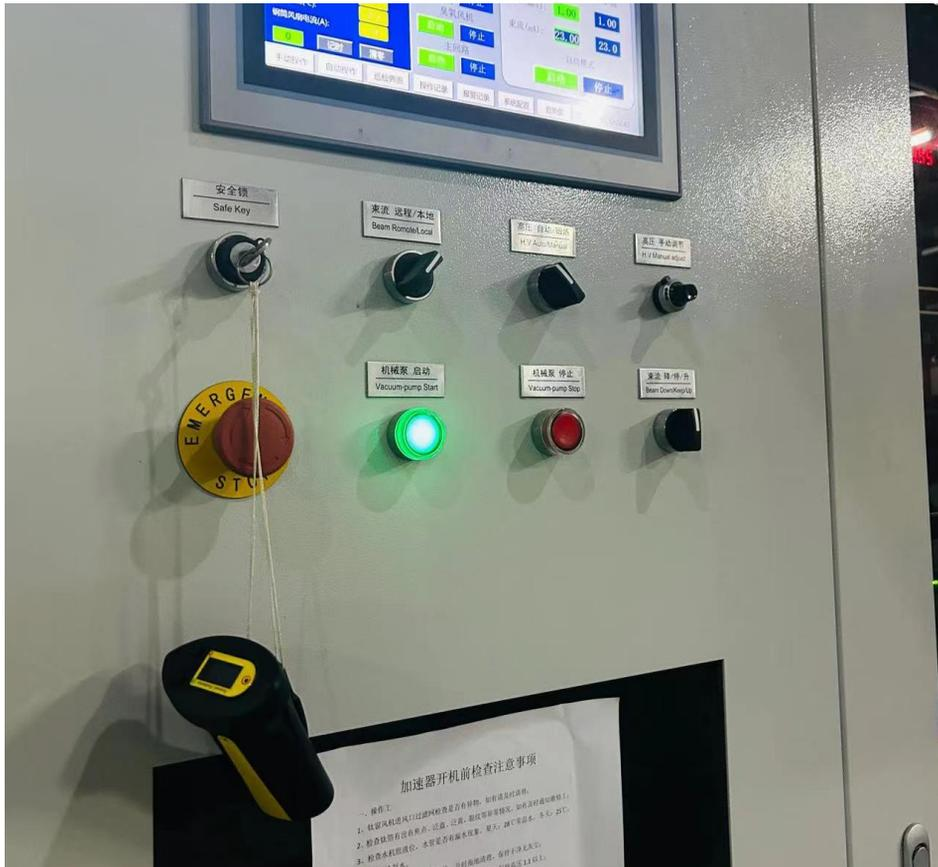
图3-4 加速器控制柜上钥匙开关
