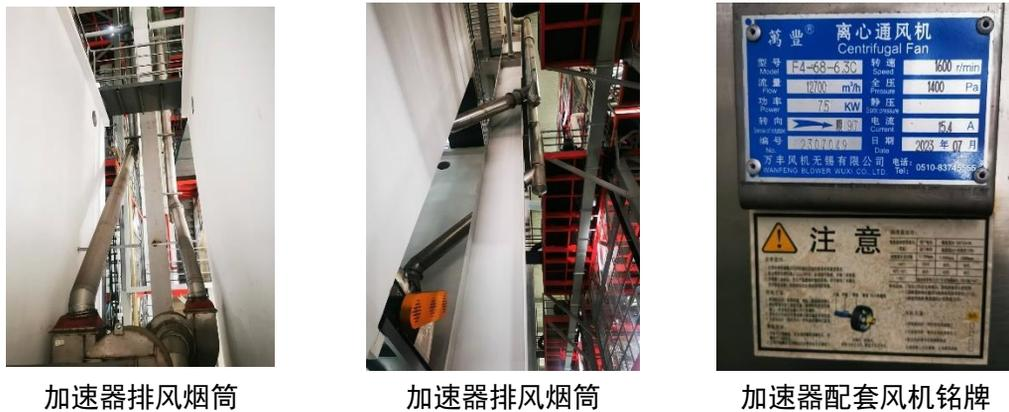
图3-11 本项目加速器机房排风系统
