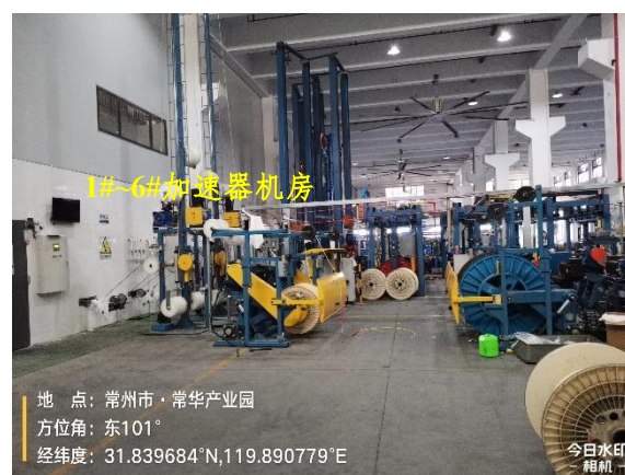
图 8-2 本项目电子加速器辐照装置项目拟建址 东侧（现有加速器工作场所）
