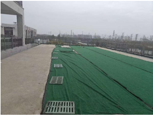
伽玛刀机房顶上平台
