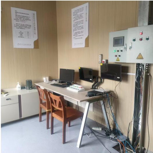
伽玛刀机房西侧控制室
