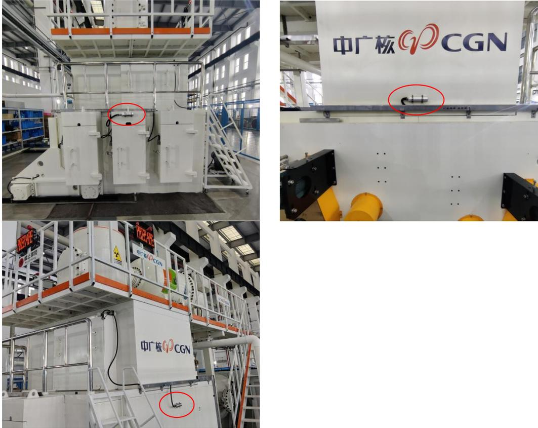
图3-5 固定式剂量监测系统
