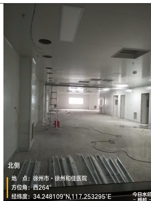
图 8-5 DSA 手术室拟建址北侧 ICU 病床区
