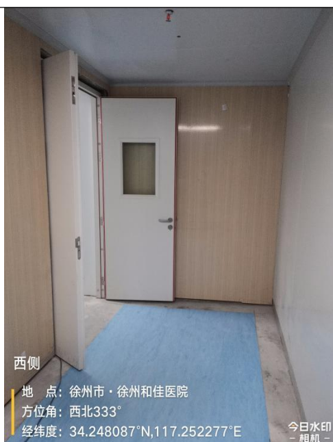
图 8-4 DSA 手术室拟建址西侧污物走廊
