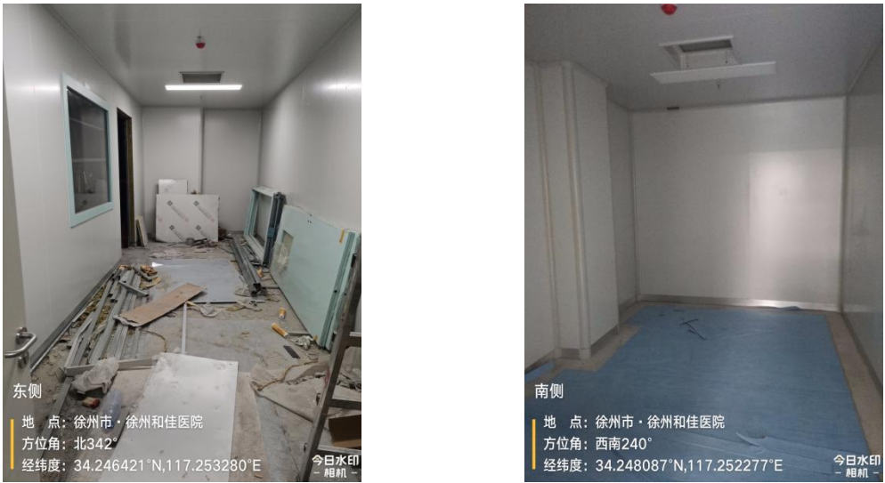
图 8-2 DSA 手术室拟建址东侧控制室拟建址
