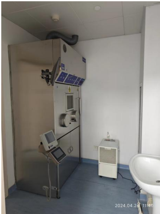
图 8-1 核医学科西区给药室
