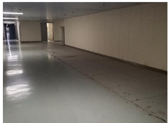
图 8-2 拟改建的医用直线加速器机房南侧(走廊)
