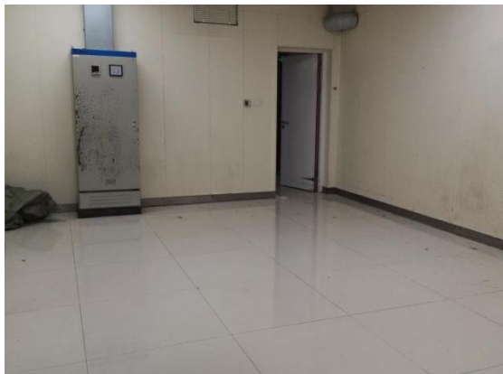
图 8-3 拟改建的医用直线加速器机房东侧(操作间)
