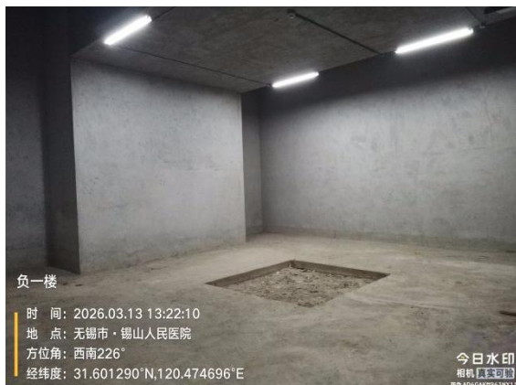
图 8-1 拟改建的医用直线加速器机房
